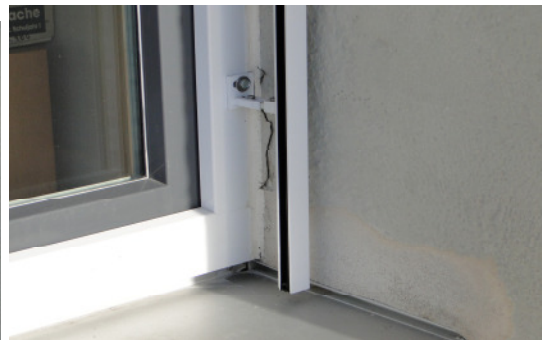
Sonnenschutzbefestigung seitlich Südfassade
