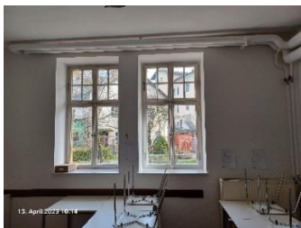
Original Holzfenster (3 Stück) 2 – flügelig mit Stulp + kippbarem Oberlicht
