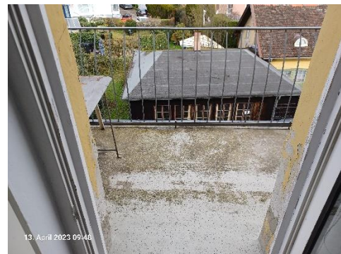
Kleiner Balkon über Dach von WC-Anlage Balkonboden und Geländer saniert
