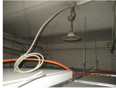
Hohlraum abgehängte Decke
