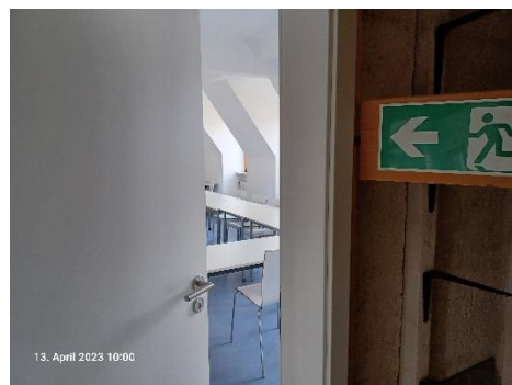
Zugang über Raum 34 zur Fluchtleiter
