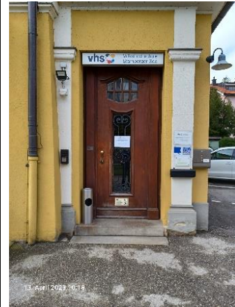
Haupteingang VHS (Treppenaufgang)
