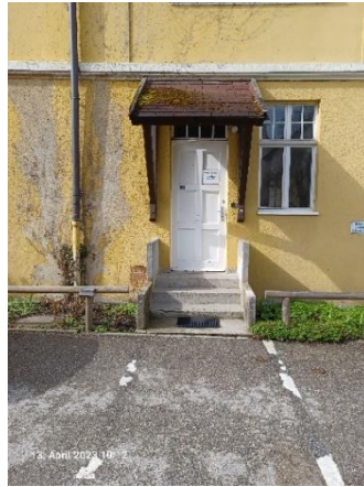
Eingang zu 2 Kursräumen im EG der VHS
