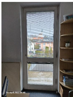
Fenstertür aus den 1970er (Isolierverglasung)
