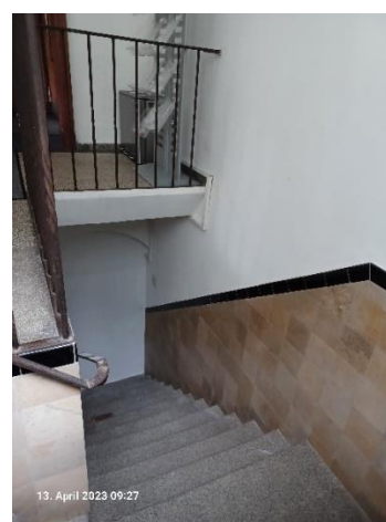
Innere Verbindung/Treppe vom EG zum 1. OG Diese Verbindung ist aufgrund der unterschiedlichen Nutzung (AWO) von der VHS hier getrennt/verschlossen.
