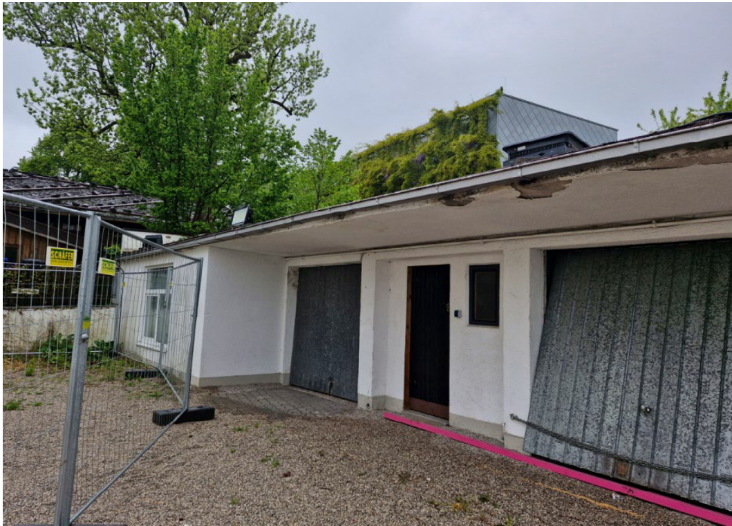
Abbildung 5: Bestandsgebäude mit geringem Quartierpotenzial, © Steil Landschaftsplanung, 05.05.2025.
