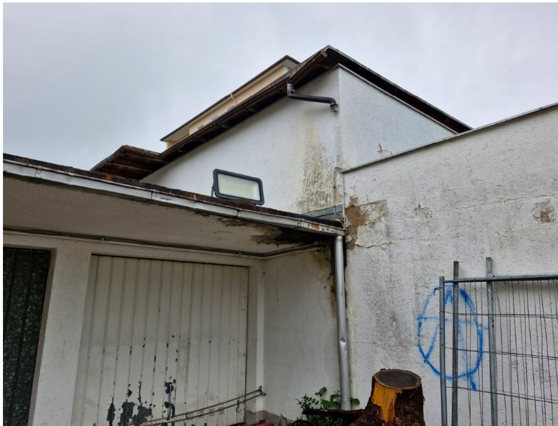
Abbildung 4: Bestandsgebäude mit geringem Quartierpotenzial, © Steil Landschaftsplanung, 05.05.2025.
