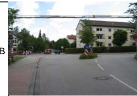
"schlecht", versetzte Fahrbahn (Foto) 3phasiger Ablauf, Knotenpunkt umbauen
