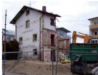
Abbruch der „Pension Eder“ im Sommer 2007.
